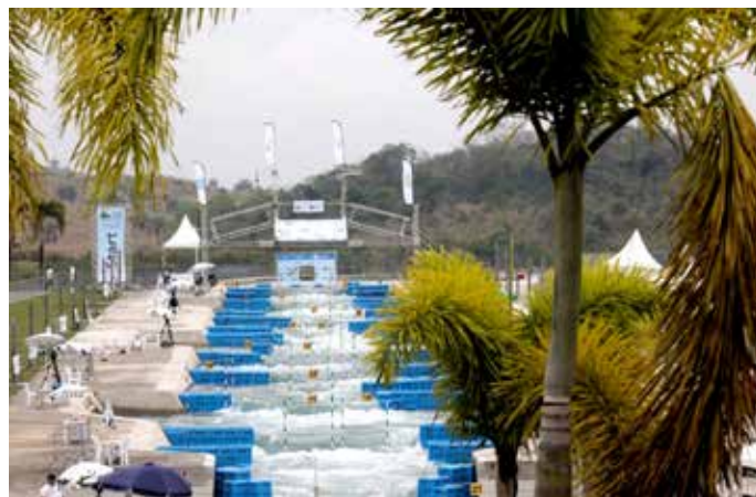
Le bassin olympique de Rio 2018, une ligne droite
