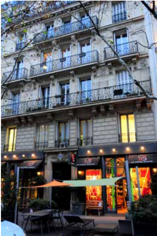
Le siège de la FFCK au 22 avenue Victoria dans le 1 er arrondissement de Paris. © Eric Poulhe, 2018
